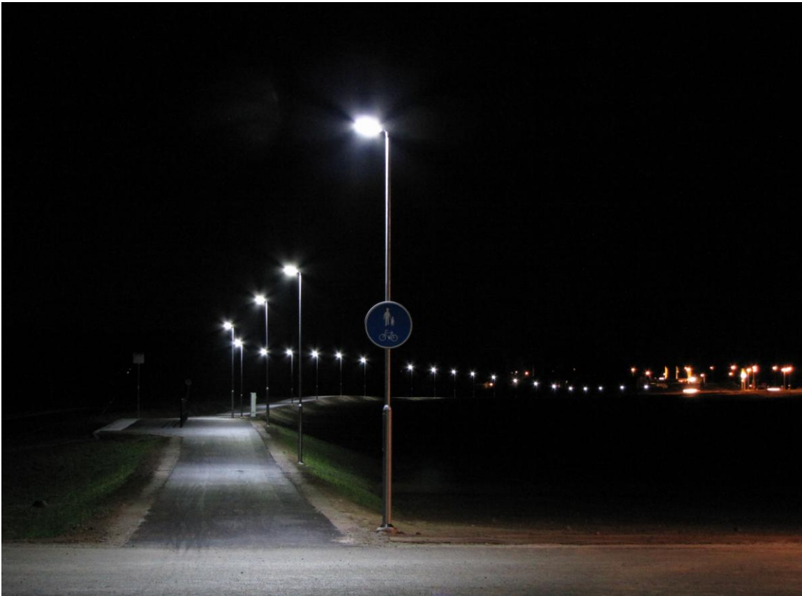
Den nya belysningsanläggningen togs i drift i mitten på oktober 2010.
